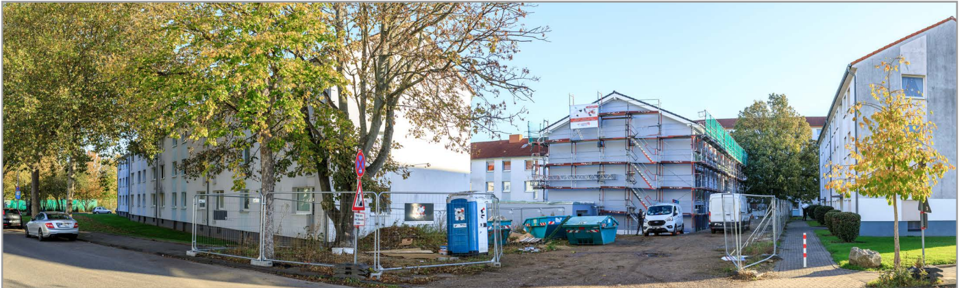
Verdichtung Gneisenaustraße – Foto: SBC Lehmann
